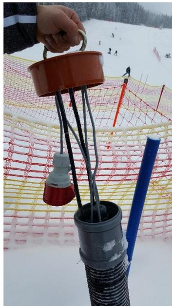
Den Deckel nach oben wegheben, dann werden die Anschlussstecker sichtbar
